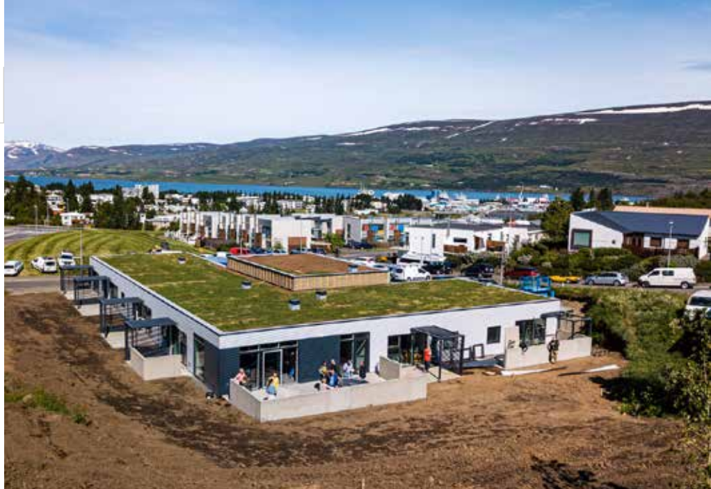
Klettaborgjir, þjónustukjarni fyrir fatlað fólk var vígður um mitt sumar 2020. Byggingin er hátt í 600 fermetrar og í henni eru 6 íbúðir auk sameiginlegs rýmis, garðs og starfsmannaaðstöðu.
