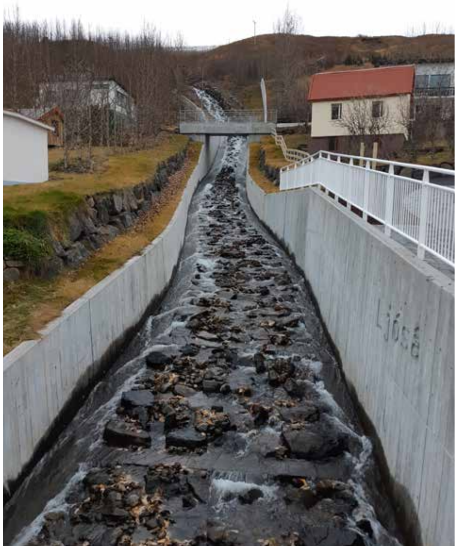
Flóðavarnir við Ljósá í Fjarðabyggð.
